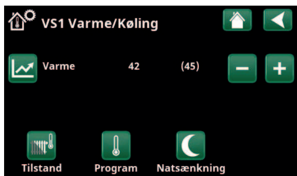
Menu "Installationsprogram/Definer/Varmekredsløb/Varmekredsløb 1". Varmekredsløbet har ingen rumfølere. Indstillingspunktet (fremløbstemperatur 45 °C) er vist i parentes, den aktuelle fremløbstemperatur 42 °C er vist til venstre for indstillingspunktet.
