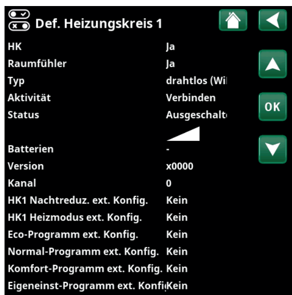
Menü: „Fachmann/Definieren/Heizkreis/Heizkreis 1“. Drahtloser Raumfühler ausgewählt
