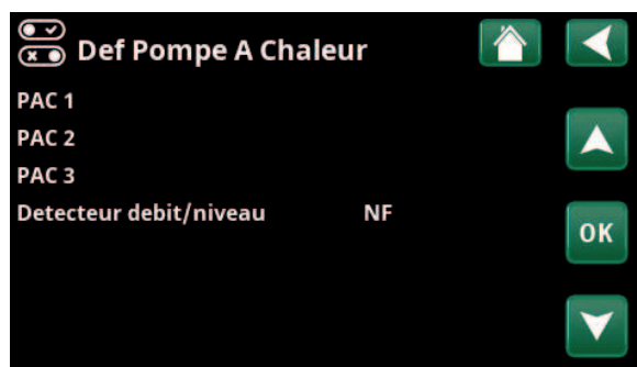
Menu : «Installateur/Définir/Pompe A chaleur». Sélectionnez une pompe à chaleur et appuyez sur «OK» pour accéder aux réglages.
