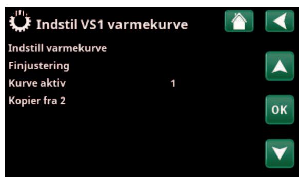
Menu "Avanceret/Indstillinger/Varmesystem/Varmesystem 1/Varmekurve".
