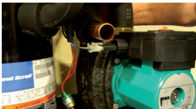
A. Montering av 3-poligt don i KB-pump
