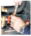
1. Débranchez le connecteur d'alimentation du module frigorifique et les tuyaux.
