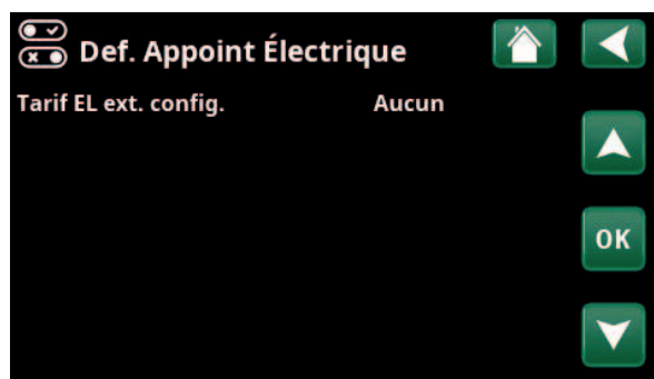
Menu : «Installateur/Définir/Appoint électrique».
